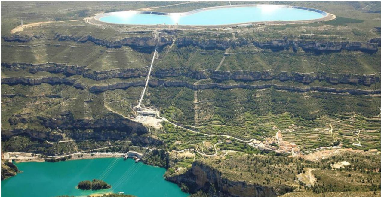
Cortes La Muela. L'impianto di Iberdrola è la più grande centrale idroelettrica a ciclo chiuso d'Europa, con una potenza di 1.8 gigawatt, quasi equivalente a due centrali nucleari
